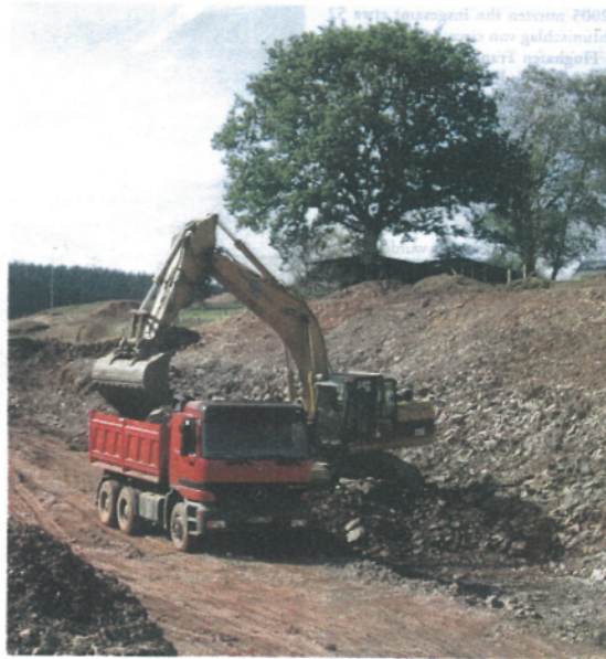
Die Straßen- und Tiefbau GmbH ist momentan am Bau der Ortsumgebung Brachthausen im Kreis Olpe beschäftigt. Mit im Einsatz sind die 50-jährige Erfahrung sowie Baumaschinen wie der Cat-Kettenbagger vom Typ 325. Foto: Zeppelin
