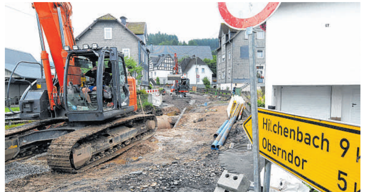
Heinsberg wird „auf links gezogen, einmal komplett umgegraben“, so einige Bürger. Nach jahrzehntelanger Wartezeit hat der Straßenbau endlich begonnen.
