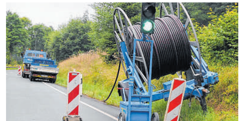
Ein Aufwasch: Eine neue Stromleitung wird zwischen Heinsberg und Albaum verlegt.
