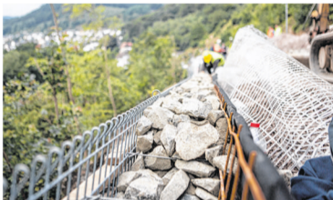
Bauarbeiten zur Hangsicherung an der B 236 in Nachrodt-Wiblingwerde: Bauarbeiter füllen die Stahlkäfige der Gabionenwand mit Grauwacke aus dem Steinbruch in Hagen-Ambrock.
