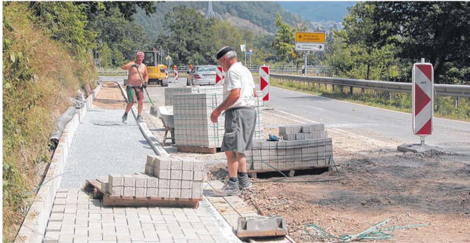
Im Bau ist derzeit der neue Gehweg vom Abzweig Bahnbetriebsweg zum Kloster Maria Königin.
